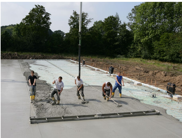
Einbringen des Betons mit Hilfe einer Rüttelbohle für höchstmögliche Genauigkeit
