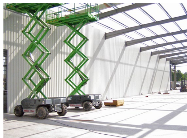
Nach dem Aushärten ist die Lagerung und Montage der Stahlteile auf der Bodenplatte möglich
