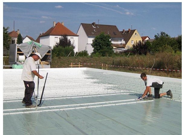
Einbau der Flächenheizung und des Heizkreisverteilers
