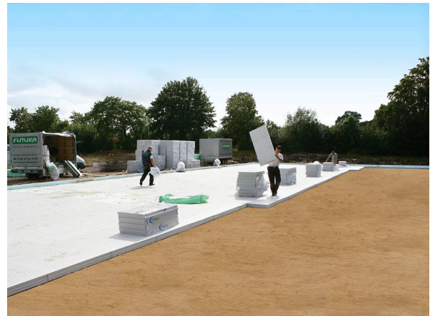
Verlegung der Flächendämmung
