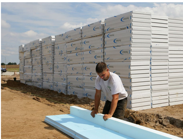
Verlegung der FUTURA-Schalungselemente aus lastabtragendem extrudiertem Polystyrol Hartschaum
