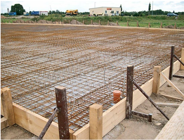
Einbringen der Bewehrung mit Lagermatten oder vorgefertigten Elementen
