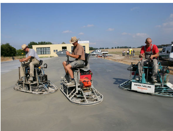
Herstellen der Oberflächenfertigkeit mit Aufsitzglättern
